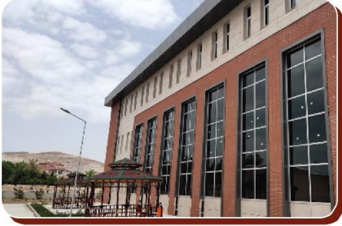
Kırşehir Halk Sağlığı Merkezi
